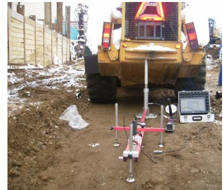
Statická zatěžovací zkouška deskou ►
