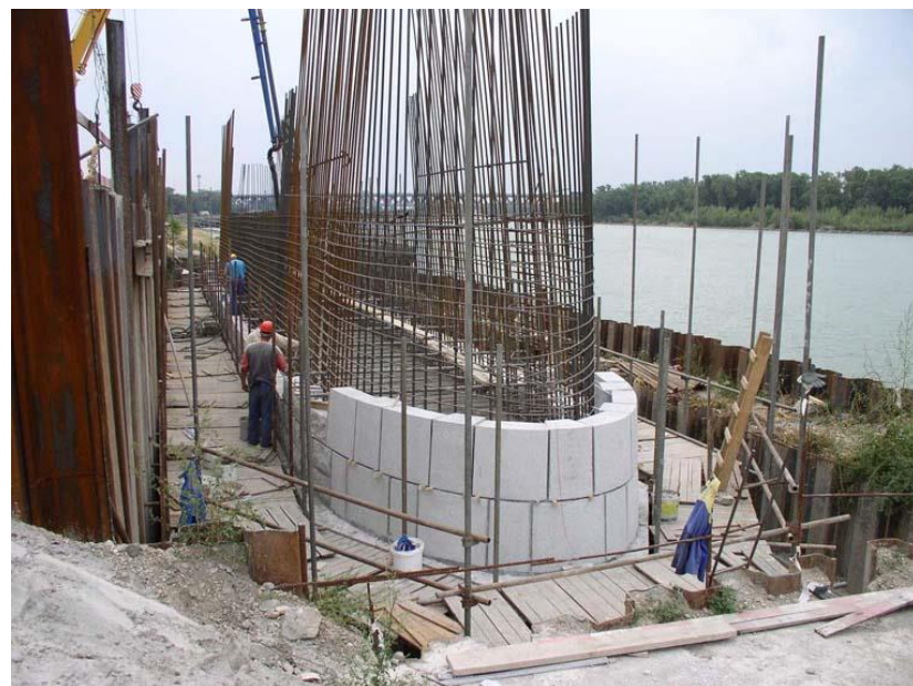
▲ Betonáž dříku podpěry do obkladu z lomového kameniva (čínská žula)
