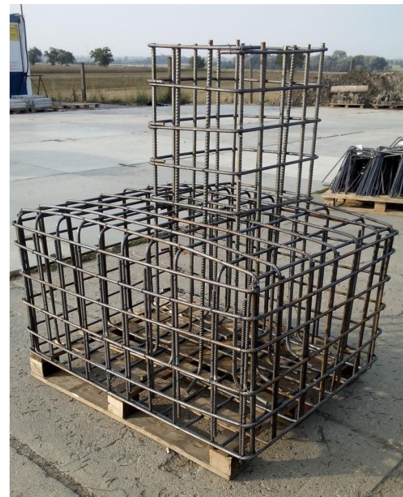
Armokoš základové patky ►
