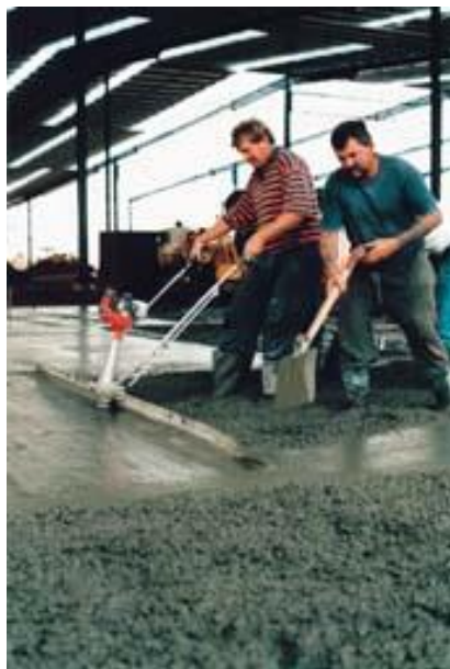
▲ Vibrační lať ručně tažená
