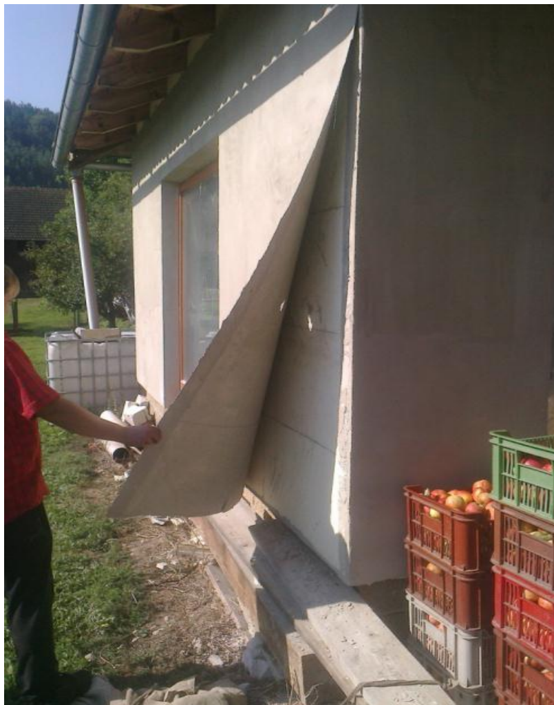
▼ Porušení přídržnosti
