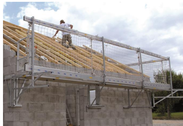
▲ Zabezpečení proti pádu pracovníků z výšky – kolektivní
