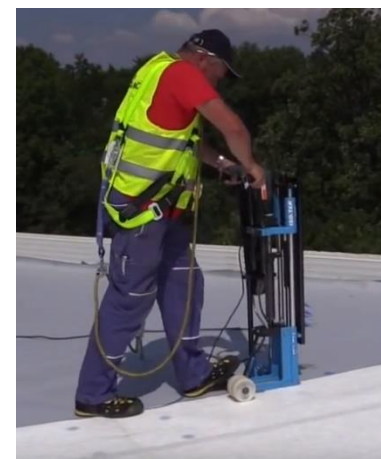
▼ Horkovzdušný svařovací přístroj
