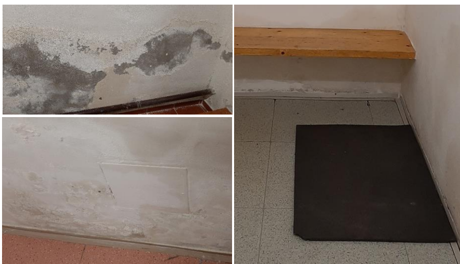
Foto 1.: Zdivo v suterénu hlavní budovy
