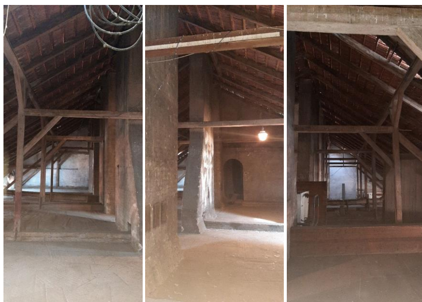
Foto č. 2. Půdní prostor v hlavní budově.
