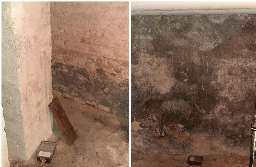
Foto 2.: Zdivo v suterénu dvorní budovy
