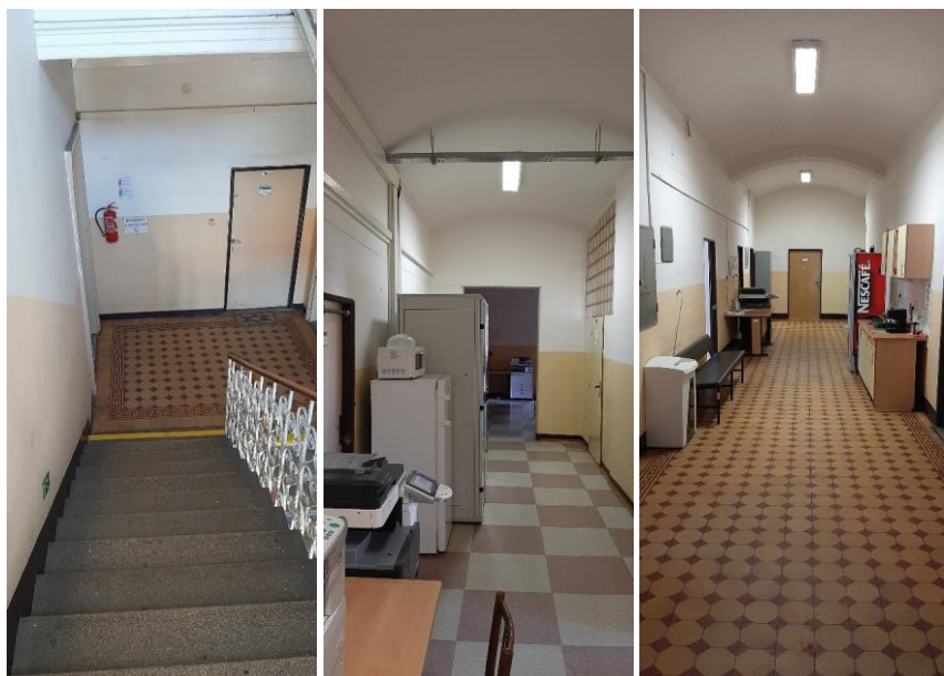
Foto č. 4. Pohled na typické provedení chodby.
